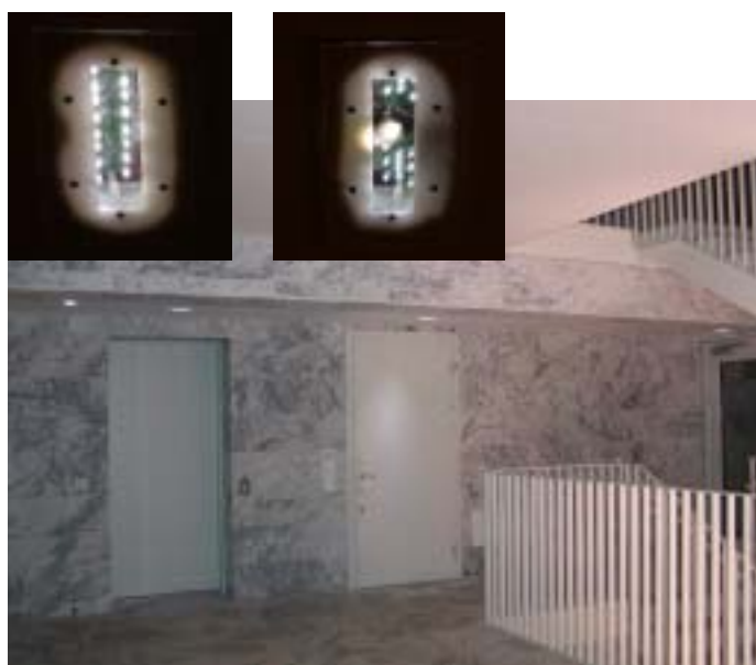
(写真 出入口付近を照らす LED 照明 (鍵穴の場所を照らしている))
